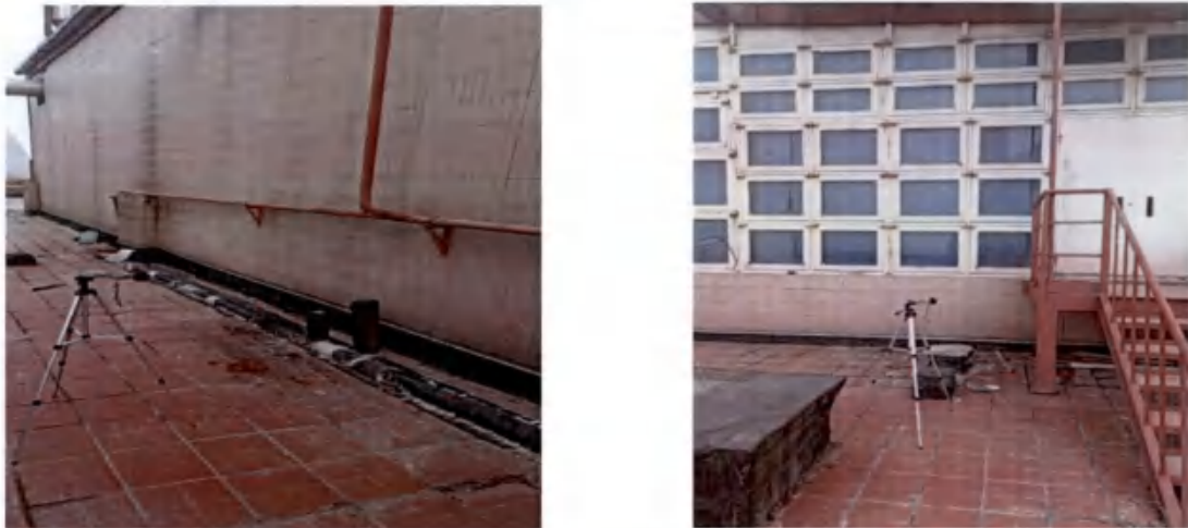
图 4-3 锅炉厂房照片
